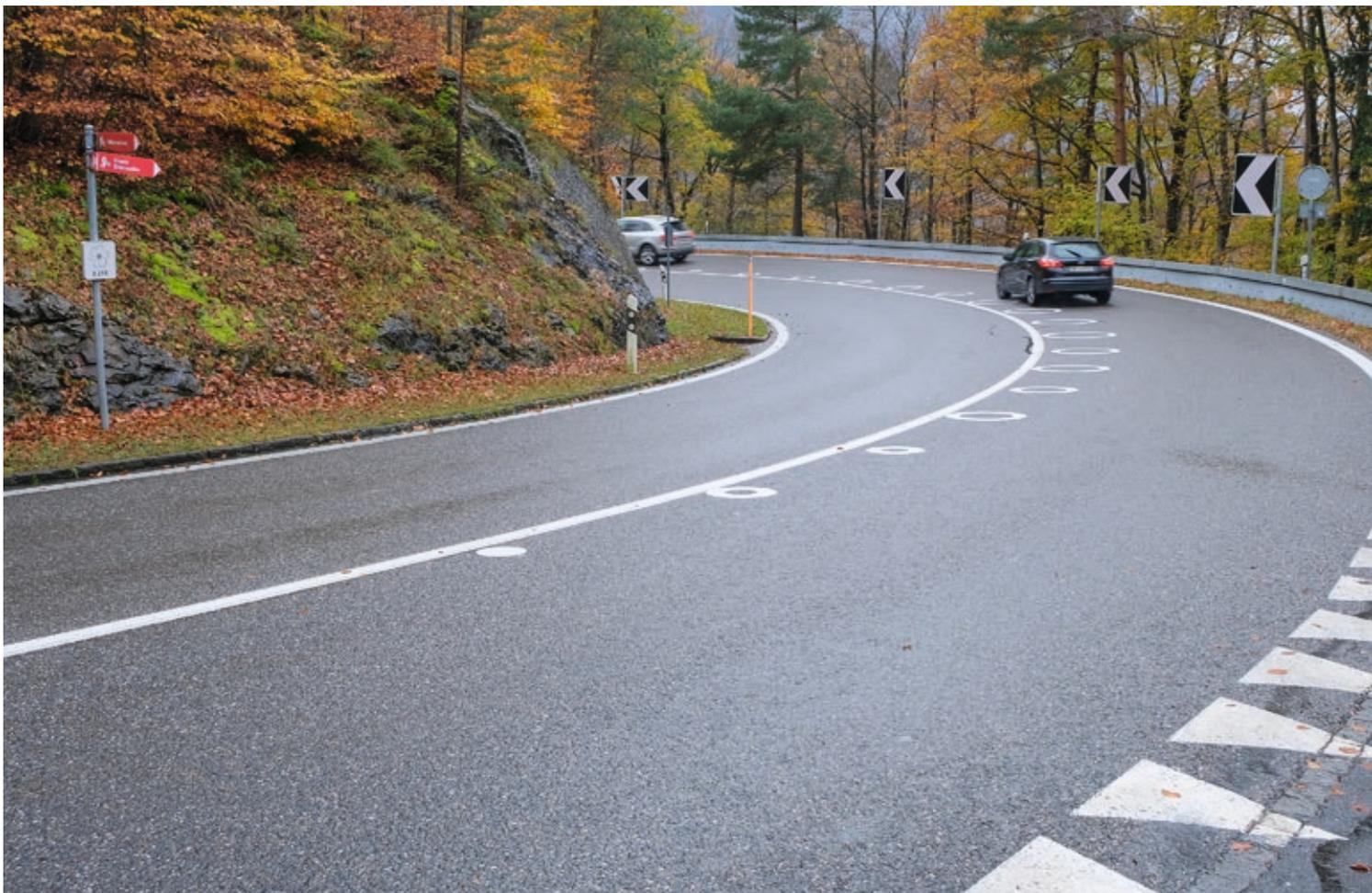
Marquage spécial composé de cercles permettant une conduite plus aisée sur la route du col du Brünig.
