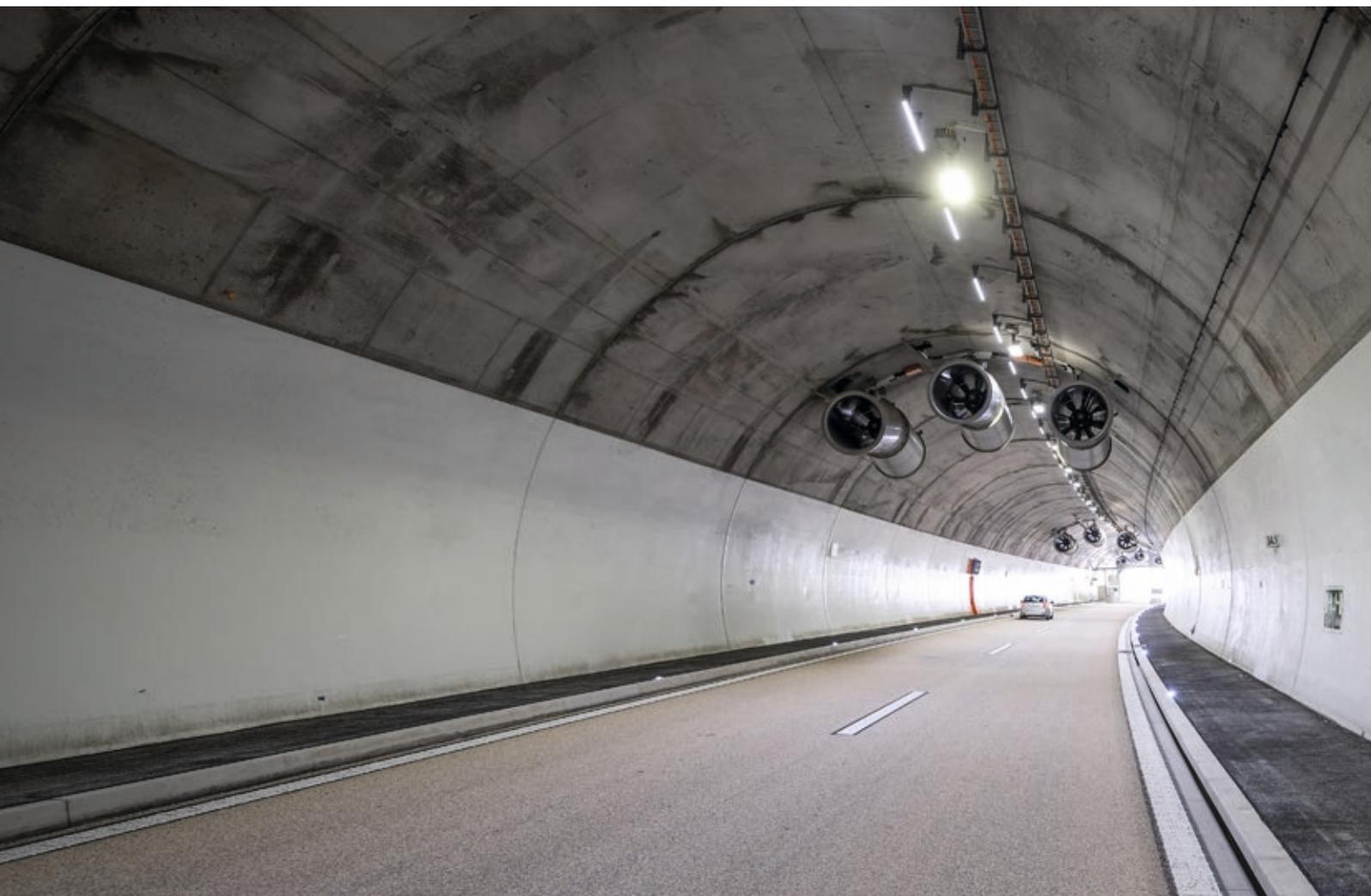
Grâce à des revêtements plus clairs, comme dans le tube de délestage du tunnel du Belchen (BL/SO), la consommation d'énergie pour l'éclairage du tunnel peut être réduite.
