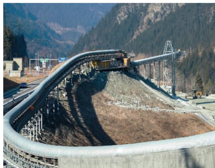
Au portail nord à Göschenen : le tapis roulant transportant les matériaux d'excavation issus de la construction du second tube routier du Gotthard.
